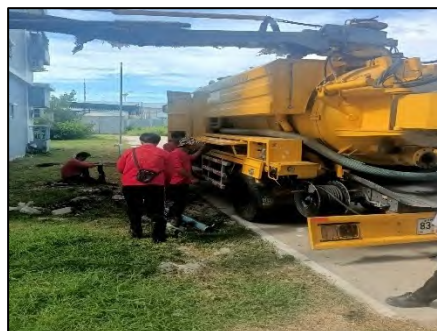
ภาพที่ 2.2-10 การสูบน้ำจากตะกอน
